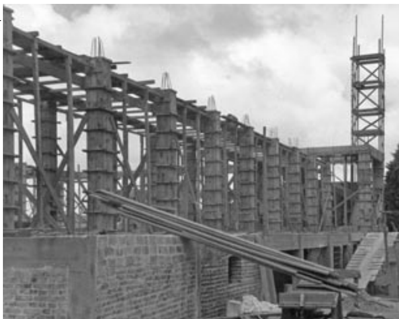
Laje principal e colunas durante a construção da nova igreja matriz, no final de 1953
