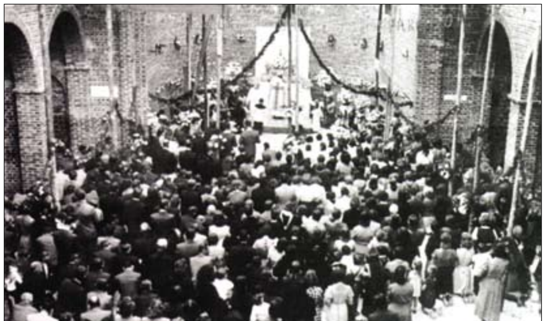
Celebração da primeira missa no templo em construção.
